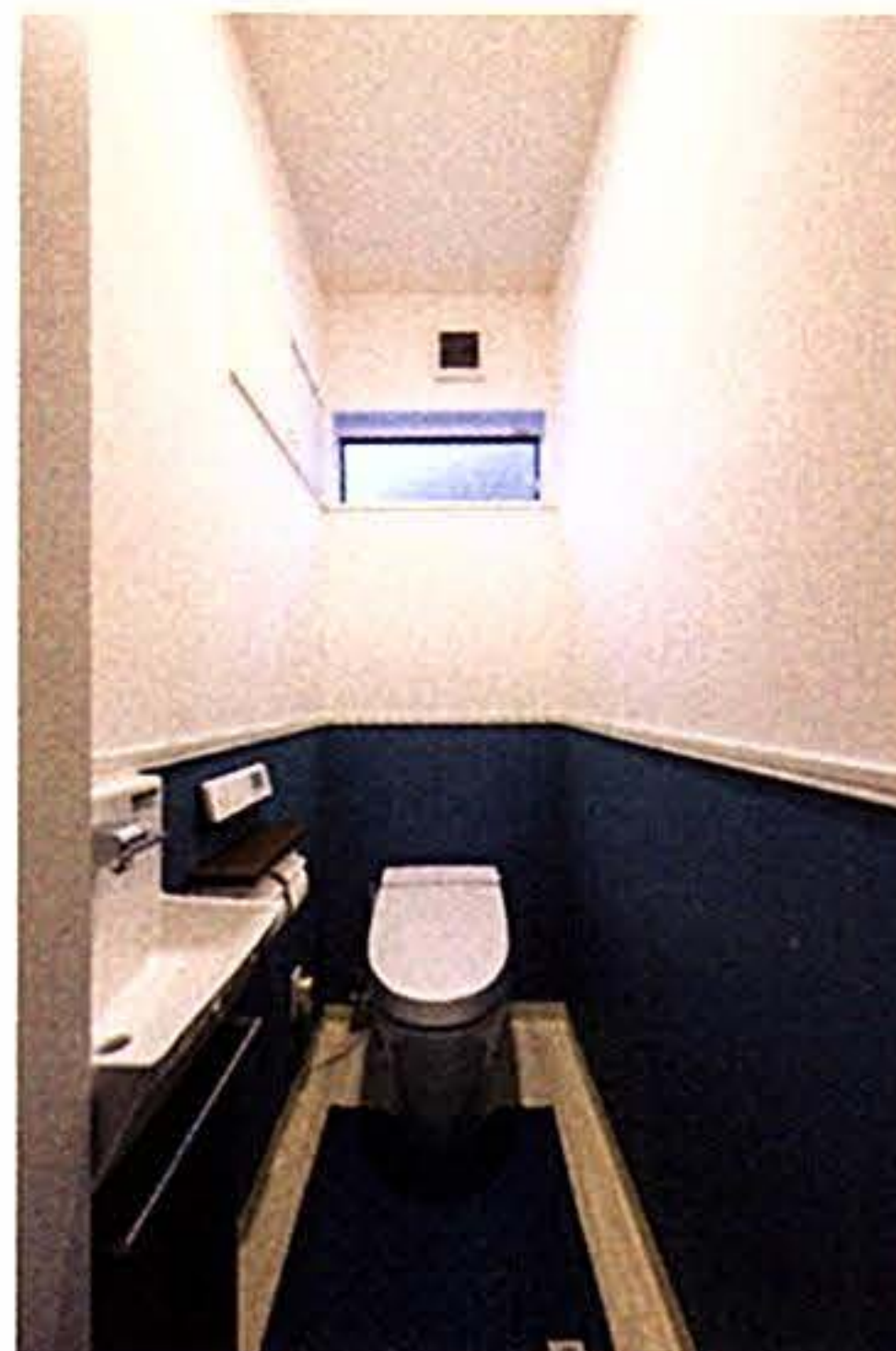
トイレの壁の一部にも、調湿や消臭の効果がある天然素材の化石サンゴを使った塗壁を採用している。
